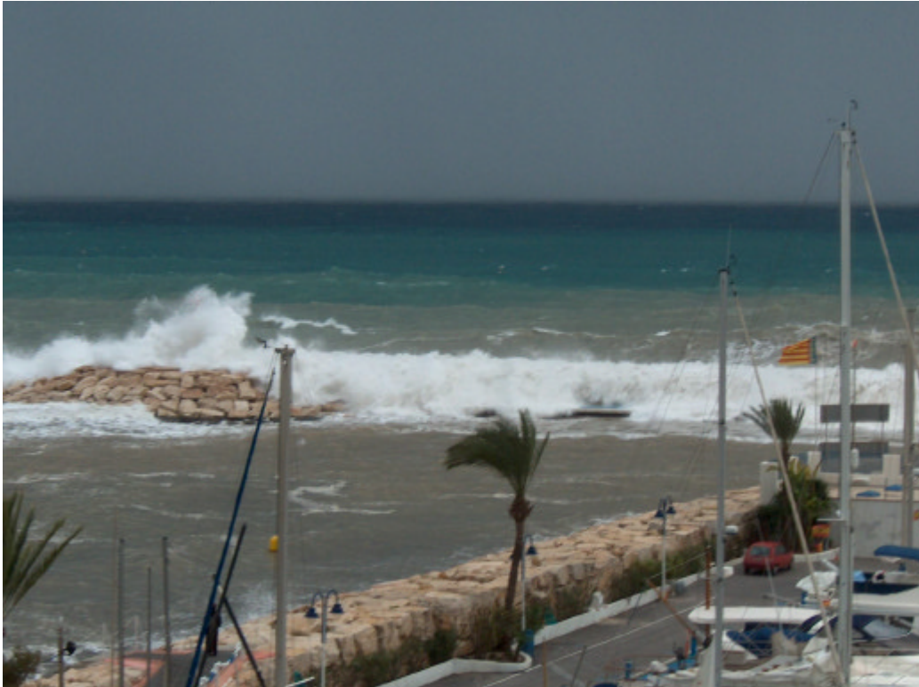
Figura 31. Olas saltando por encima de la escollera del rompeolas de Moraira durante el temporal del 31 de octubre de 2003.
