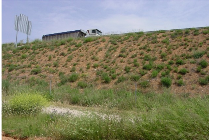
Fotografía 4.1. Se muestra un talud colonizado únicamente por M. sativa en el que la diversidad es muy baja y no se ha llegado a colonizar totalmente.
