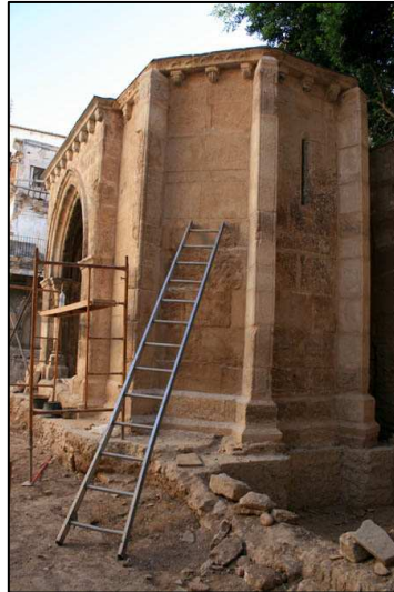
La Capilla de Jaime I durante el proceso de restauración
