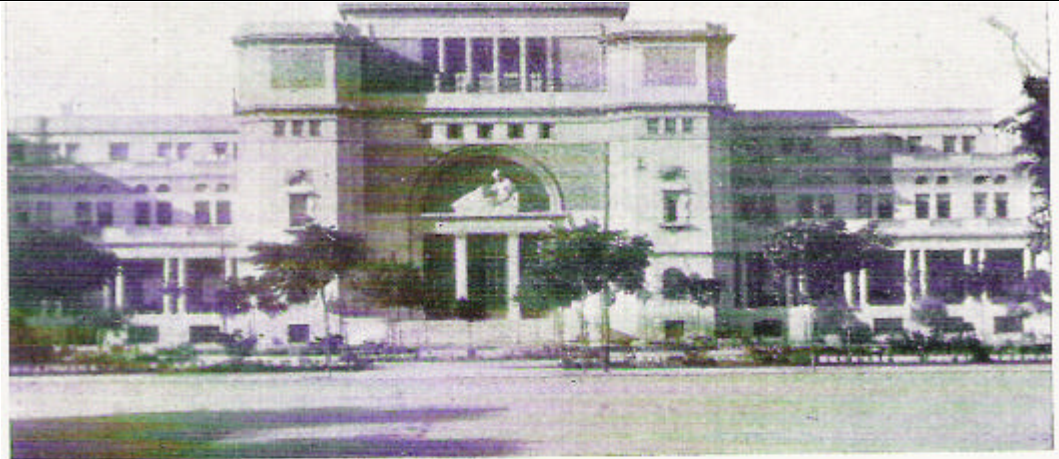
Cuerpo central de edificio de la nueva Facultad de Medicina, emplazado en la anchurosa avenida titulada «Paseo de Valencia al Mar»
