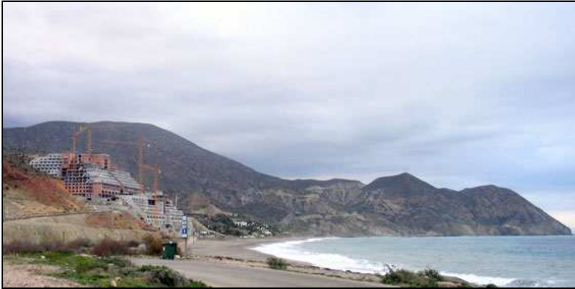
Figura 196: Construcció de l'hotel a l'Algarrobico en 2005 en el bell mig del parc natural. Fotografia. Asociación de Amigos del Parque Natural del Cabo de Gata-Níjar.
