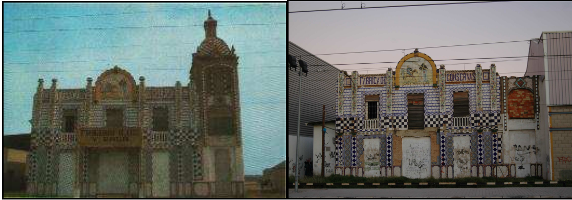
Figura 148: Fàbrica de conserves d'estil modernista a Catarroja. Ja en 1981 era un edifici abandonat i deteriorat. En 25 anys s'ha deixat caure literalment i està en greu perill d'enfonsament. Li falta la torre i ha quedat enquistat entre dues naus industrials al costat de l'estació de RENFE d'aquesta localitat. Fotografies: VILA (dir.), 1981 i Luis del Romero.
