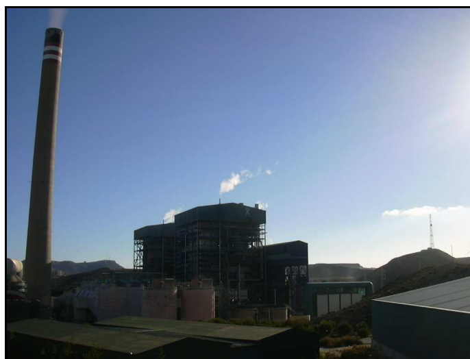
Figura 180: Planta tèrmica junt a la dessalinitzadora de Carboneras. Fotografia: Luis del Romero.
