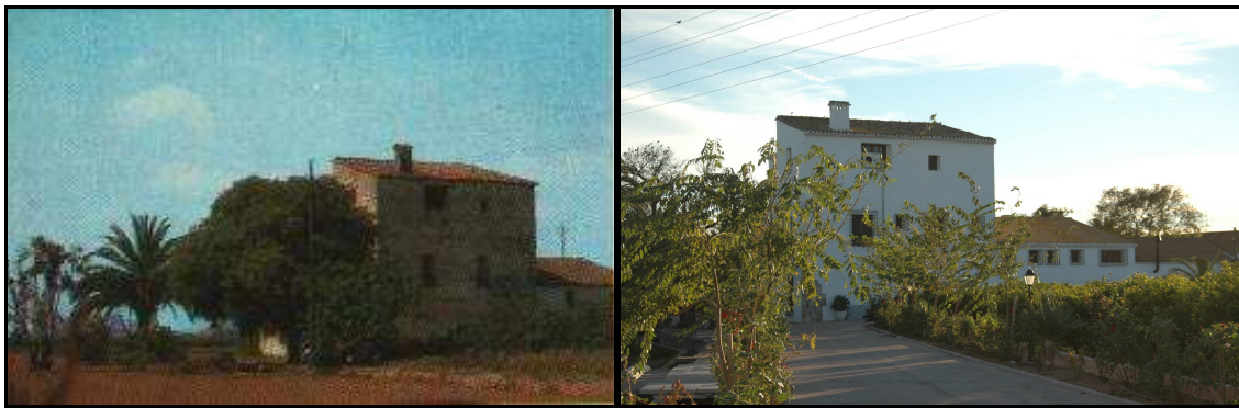
Figura 146: Alqueria Alta a Picanya. A 1981 era encara una alqueria amb conreus d'horta en actiu encara que l'edifici estava deteriorat. Hui en canvi s'ha convertit en un xalet de luxe amb tanca, porter electrònic i jardí . Fotografies: VILA (dir.), 1981 i Luis del Romero.
