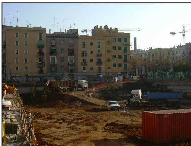
Figura 58: Projecte de transformació urbana a l'illa del carrer Robadors. Foto: Luis del Romero.
