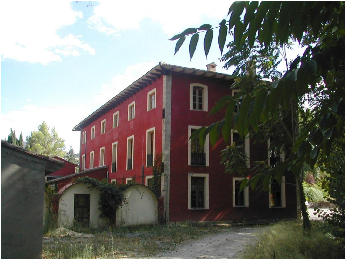
Fig. 88- Fotografia actual de l'edifici del Balneari de Benimarfull (Font: Juan Serrano. Alicantevivo)
