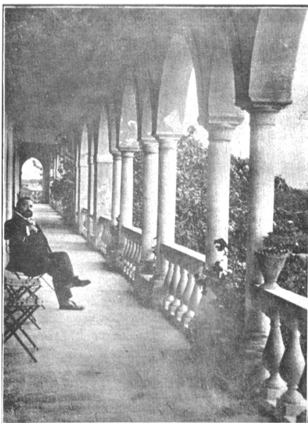
Fig. 117- Claustre de les columnes de l'establiment de l'Estrella a la Vilavella
