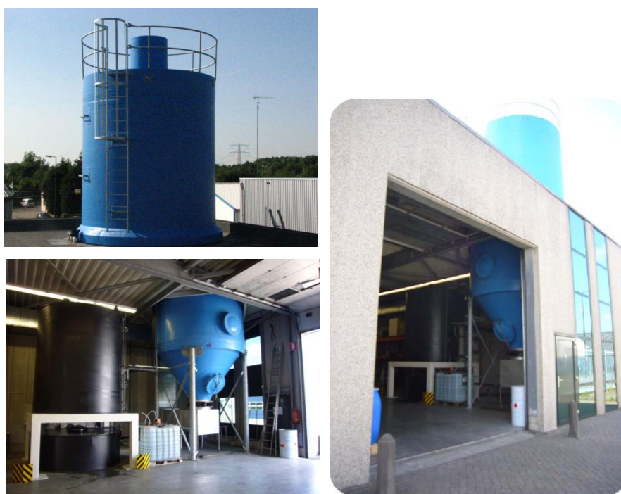
Figura 4.5. Fotografies del prototip industrial de biofiltre percolador (VOCUS®).
