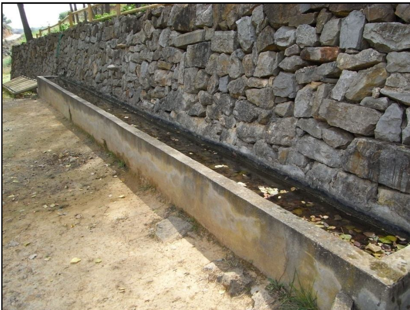
Fotografía 32. Abrevadero en Font de la Ponsa (Les Useres, 2008).
