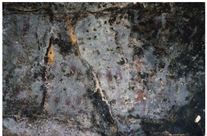
Fig.II.180. Zona C del Cinto de las Ventanas.
