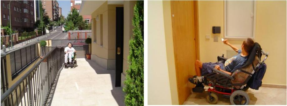
Fig. 70.- Rampa exterior de acceso a los pisos y sistema de apertura-puertas por llavín-sensor
