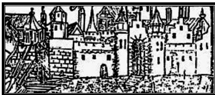
Fig. 27. Detalle de la vista urbana de los grabados del Estado de Milán, Historia de las cosas que ha pasado en Italia (1536) de Galeazzo Capella.
