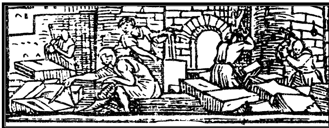
Fig. 4. Detalle del grabado de la construcción de la muralla, Primera parte de la coronica (1546), de Pere Antoni Beuter.
