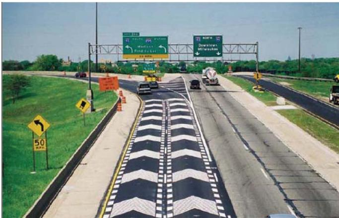
Imagen 2. Marcas chevron instaladas en Milwaukee, Wisconsin. Tomada de Drakopoulos & Vergou, 2003)
