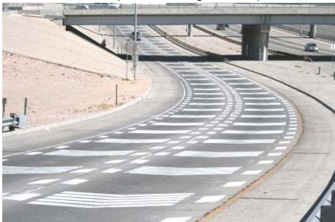
Imagen 3. Marcas chevron implantadas en la aproximación al conector US54 con IH10 en El Paso, Texas. Tomada de Voigt et al. (2008)
