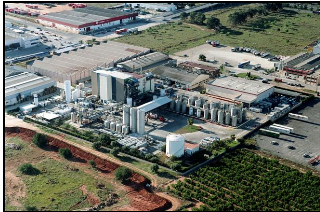
Fig. 1.1: Vista aérea de la planta de PPG Ibérica en Quart de Poblet
