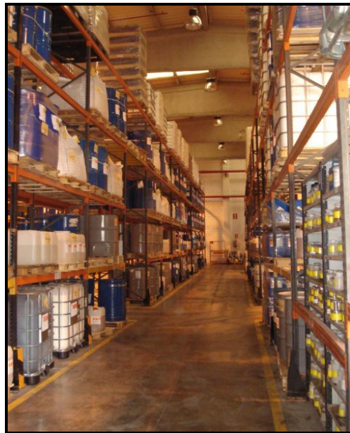
Fig. 1.6: Nave de almacenamiento de productos inflamables
