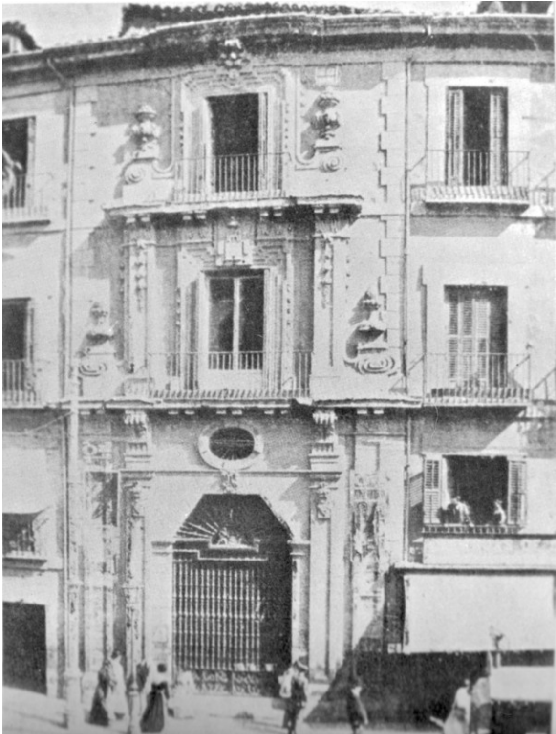
L'Hospital de Montserrat de la Corona d'Aragó a Madrid, abans del seu enderrocament en 1910
