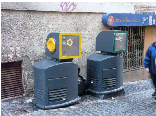
Imagen 9. Recogida selectiva de envases ligeros y vidrio en Burgos, España. Sistema de recogida neumática.
