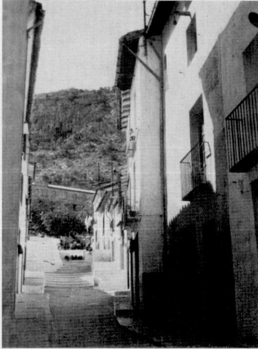
Fig. 1 —Calle de las Santas, al pie del cerro del castillo. Caserío escalonado.
