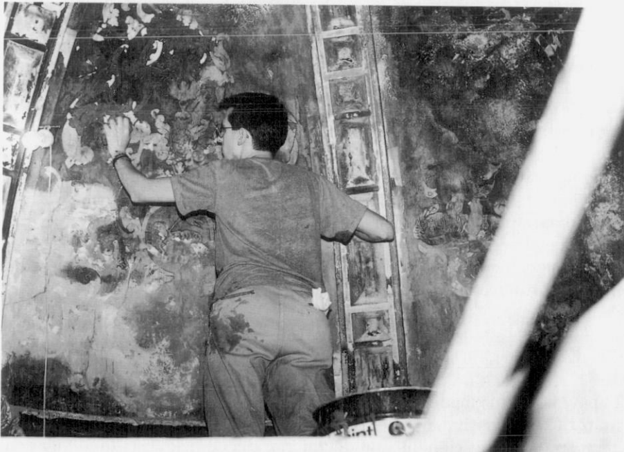
Foto 4. Trabajos de reparación de la cúpula del trasagrario.
