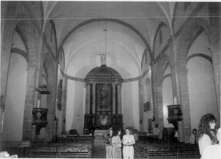
Foto 6. Presbiterio de la iglesia después de los trabajos.
