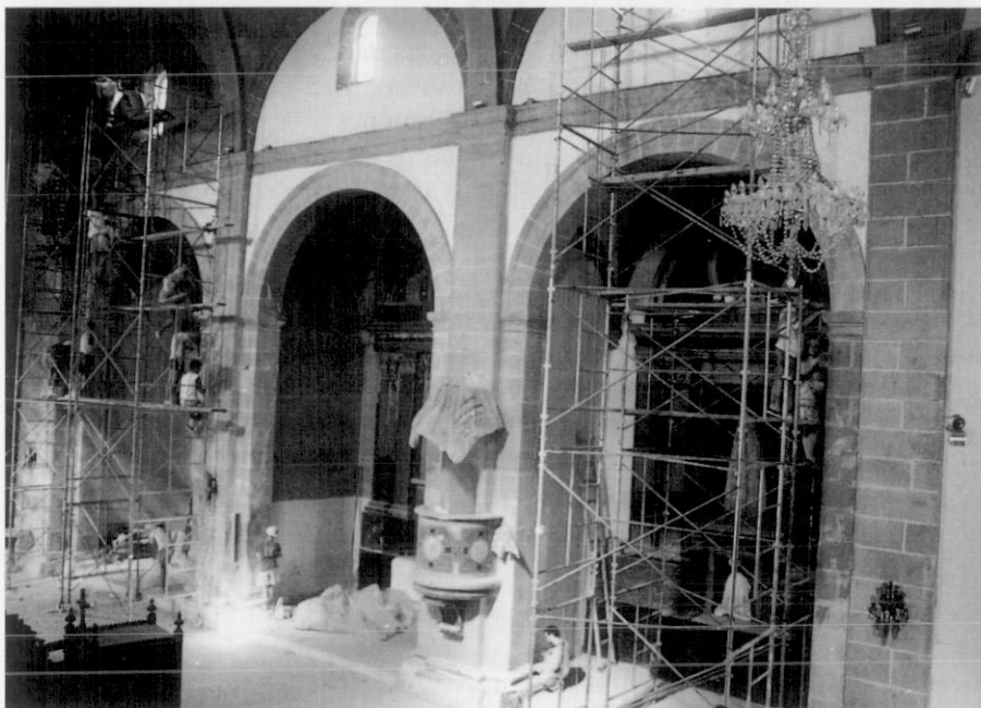
Foto 1. La nave de la iglesia durante los trabajos.
