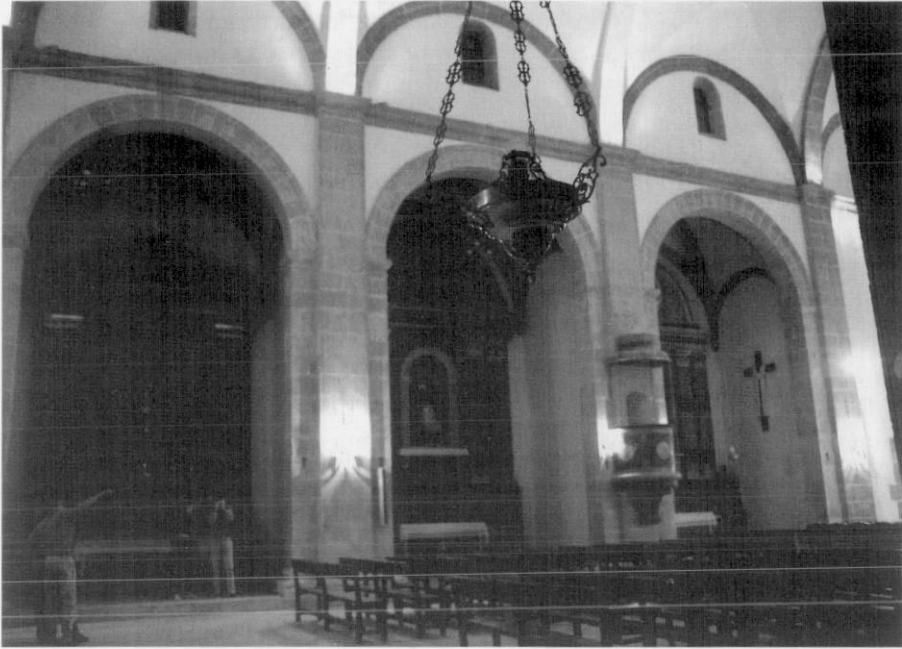
Foto 7. Nave de la iglesia después de los trabajos.
