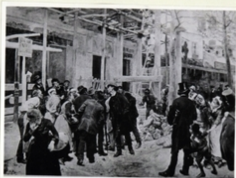
Fot.XXIX- JIMENEZ ARANDA, J. La caída del andamio (1890)
