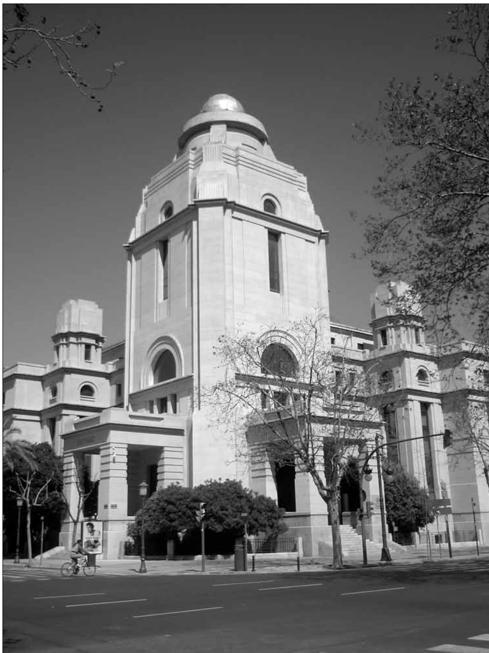
Facultad de ciencias de Valencia, acabada en 1944, siendo rector Fernando Rodríguez Fornos. Arquitecto Mariano Peset Aleixandre.
