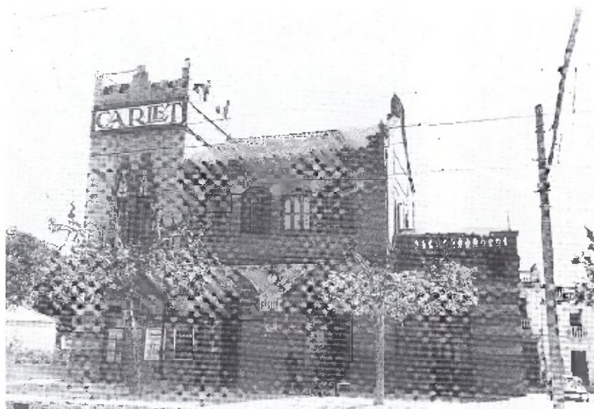
3. Nueva Estación de Carlet, construida en 1925. AFGV.
