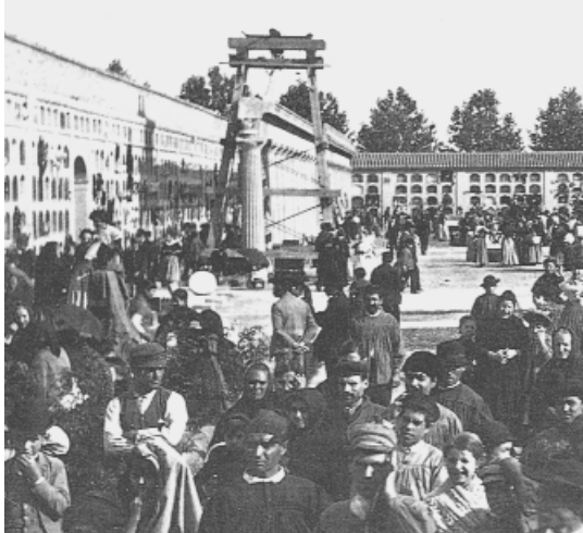
Fig. 9. Construcción de los pórticos. Detalle de foto de 1888 de la firma Lévy con el cuadro del ensanche donde se ubican aquéllos.
