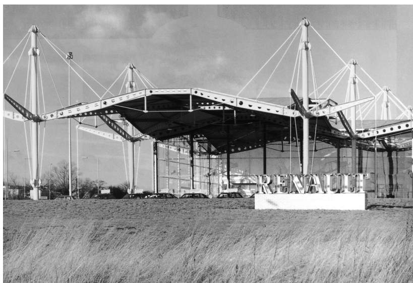
6. Norman Foster & Associates, Centro de distribución y de recambios Renault, 1983, Swindon.
