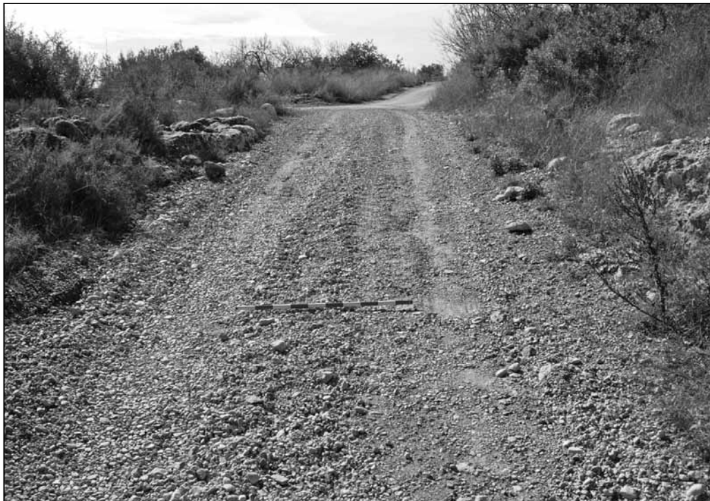
Figura 11. Fotografia actual de l'extrem superior de la rampa de la vora oest.
