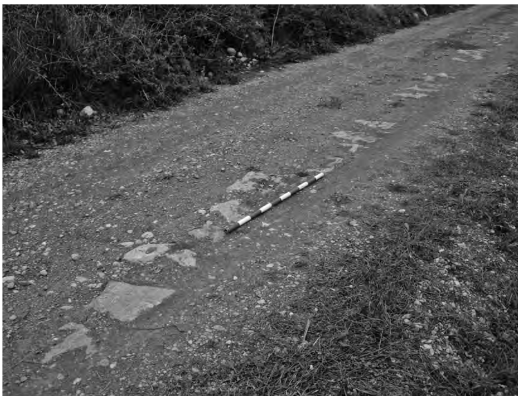
1.- Alineación de piedras correspondiente a uno de los bordillos de la vía visible en El Camí de les Llacunes (Sant Mateu, Castellón).
