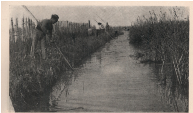
Consolidado el terreno se cubre de fango, que se extrae con azadas de mango largo. Foto O. S. Colonización.
