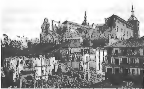
La torre NO se derrumba el 8 de septiembre de 1936.
