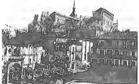
Antes de la explosión de minas del 18 de septiembre de 1936.
