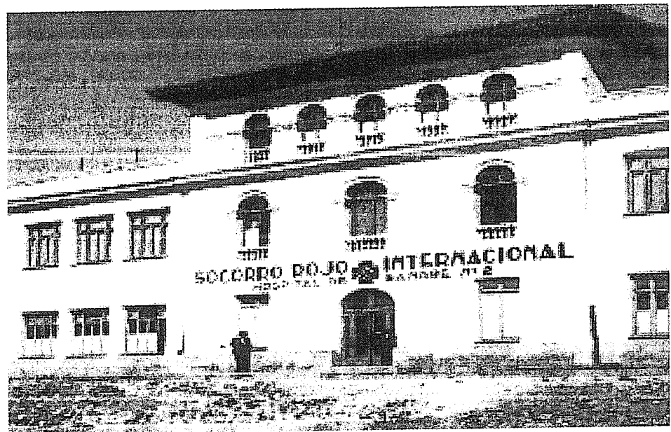
Edificio del Grupo Escolar de la partida de Los Ángeles, promovido por E. Gómez Serrano. No llegó a funcionar, debido al estallido de la guerra, en la que fue hospital de sangre y luego hospital militar.
