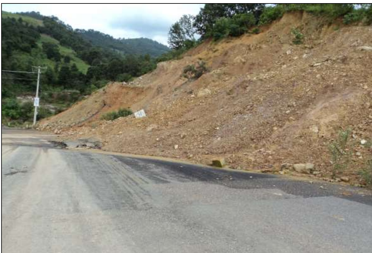
Vista parcial de la carretera Marquelia - Atlamajalcingo del Monte, Guerrero.
