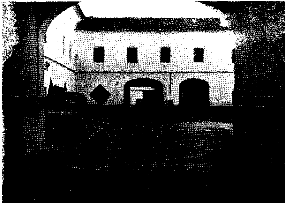
Patio interior de una masía.
