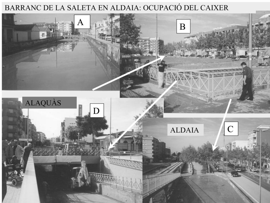
Foto 7. El Barranc de la Saleta a l'entrada d'Aldaia conserva un caixer artificial d'escassa capacitat (a); tanmateix, a poca distància desapareix totalment, sent ocupat per un passeig (b), que a la vegada està confinat pel traçat de la via del ferrocarril (c). Les aigües del barranc arriben a Alaquàs a través d'un pas subterrani (d). En realitat, en aquest exemple no es pot parlar de processos d'inundació en sentit estricte; més be caldria parlar d'ocupació del caixer.
