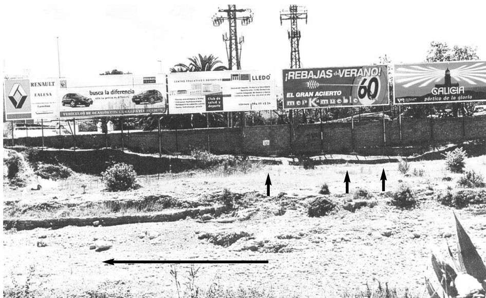
Foto 3. Punt de trencament del Riu Sec de Borriol (fletxes verticals) aigües amunt del pont de la carretera homònima. En estar el marge dret més baix que l'esquerre les aigües se'n surten de mare amb molta facilitat (la fletxa horitzontal marca la direcció de les aigües).
