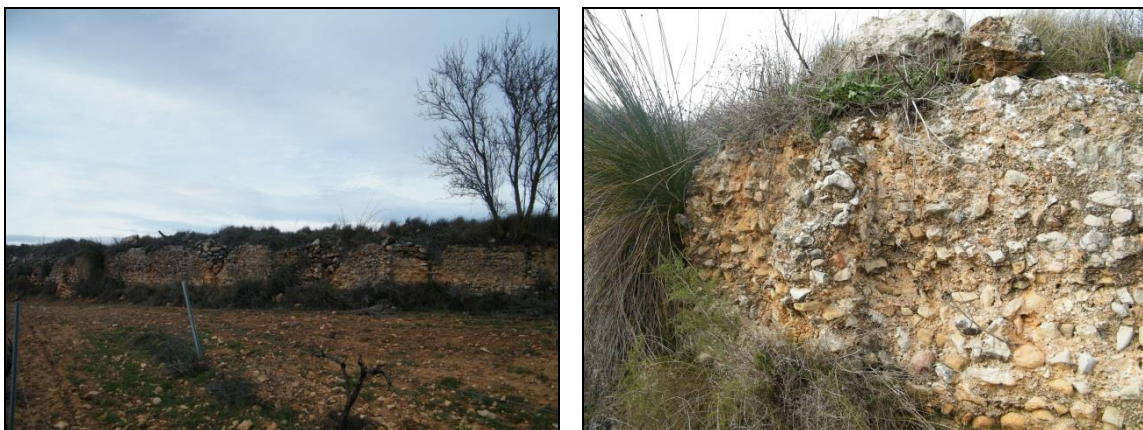
Figs. 41 y 42: Vista de muro de opus caementicium y detalle de uno de sus contrafuertes.
