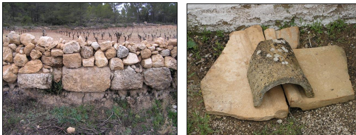
Figs. 71 y 72.: Sillar reutilizado en una horma (izq.) y restos de material constructivo de gran tamaño (der.).
