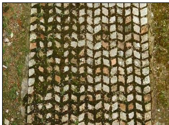
Fig. 34: Pavimento romano de ladrillos romboidales encontrado en las excavaciones de la Plaza del Castillo.
