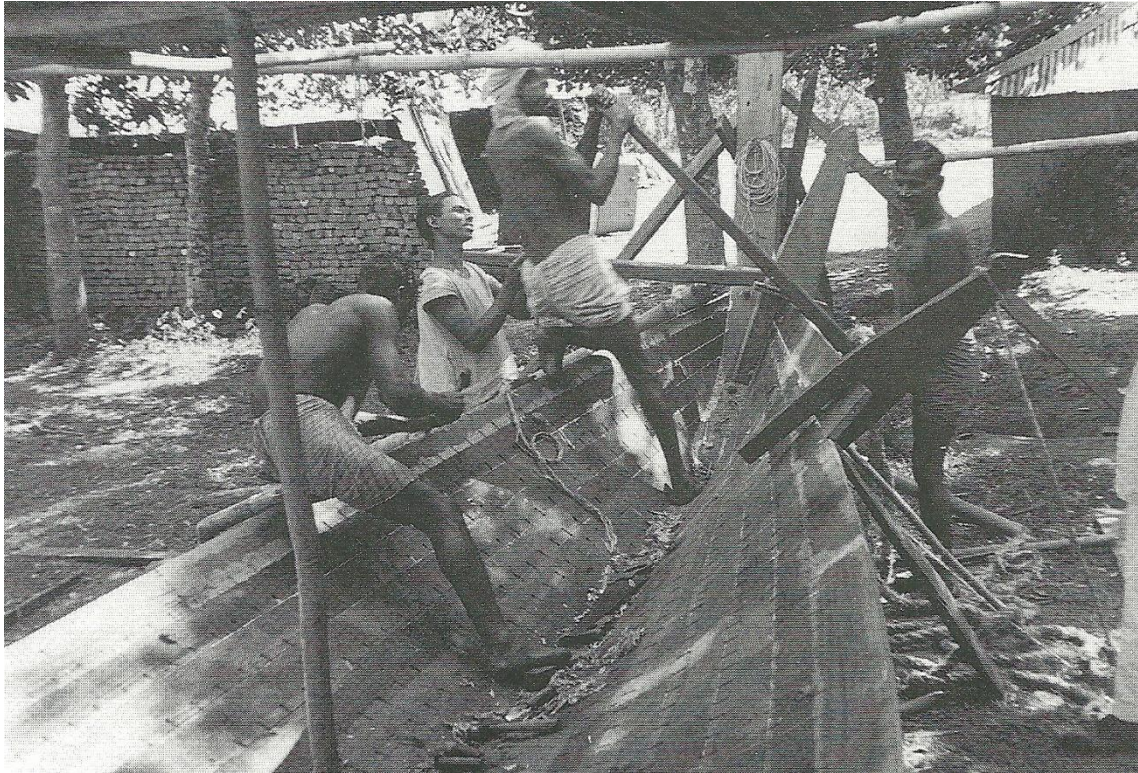
Fig. 28.- Unión de una traca con la roda en un barco de transporte construido a casco primero en Bangladesh, donde las cuadernas son secundarias en la estructura del barco, que reside en el casco. Obsérvese los tensores para dar las formas a las tablas (Greenhill, Morrison 1995: 41).
