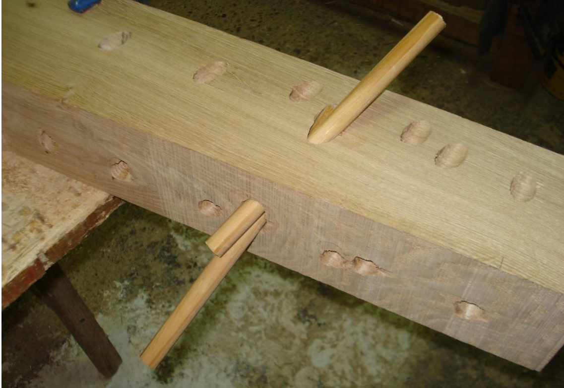
Fig. 445.- Vista del ejercicio de ensayo del sentido de la perforación y colocación de una cabilla para que una fije a la otra. Por los ángulos que describen las trayectorias de éstas no parece lógico que las perforaciones se hicieran desde el exterior del casco, sino desde el interior.
