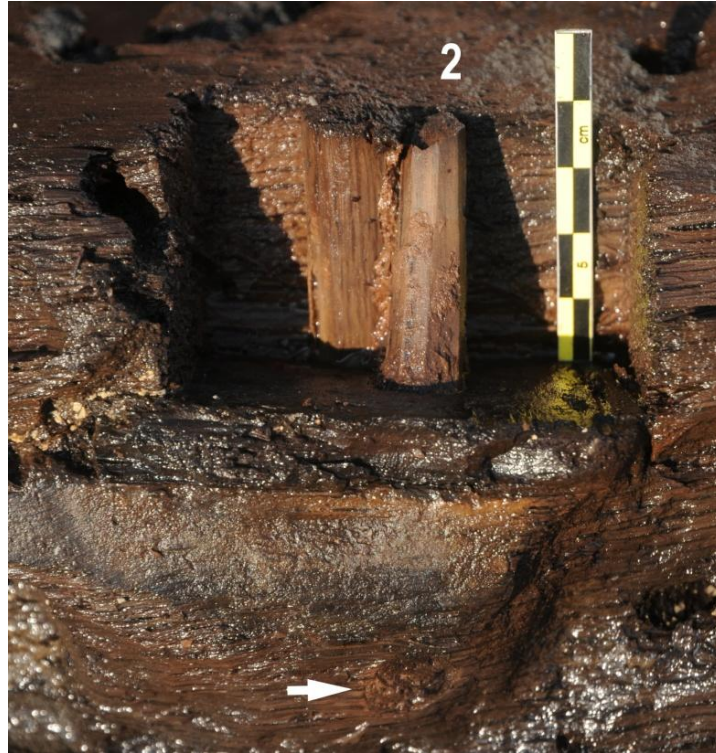
Fig. 311.- Vista de la cara lateral Oeste donde tras el vaciado mecánico se observa la factura de las dos clavijas. La insertada (flecha) desde el exterior del casco, facetada, está fabricada a cepillo carpintero. En la introducida desde el interior del casco y que no atraviesa completamente la quilla no se distinguían tales marcas (Foto: Seguin).
