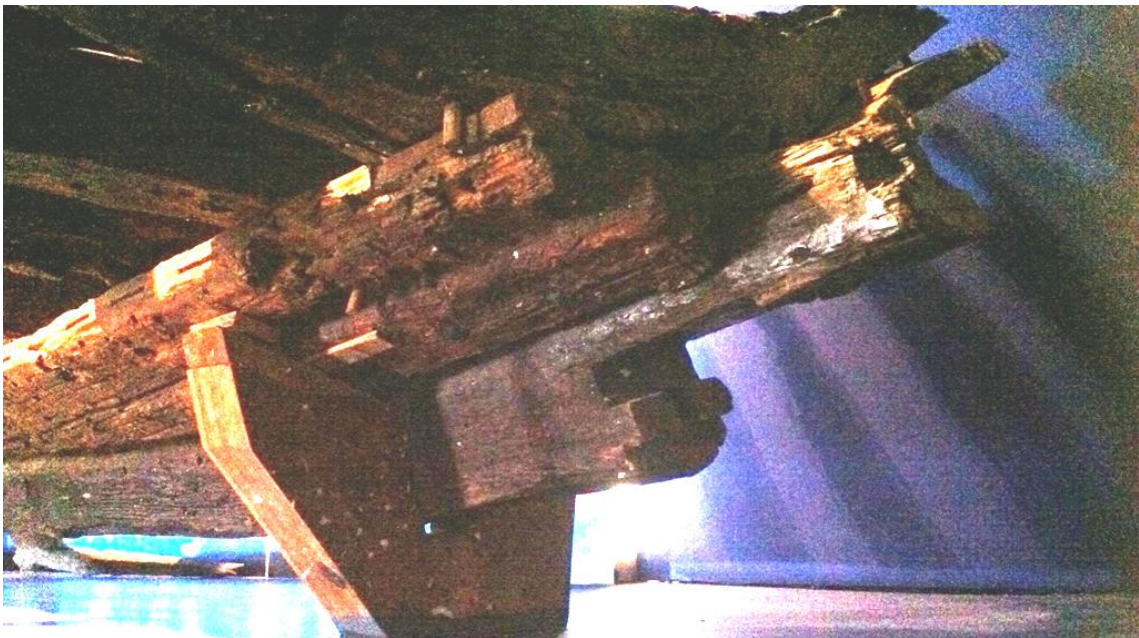
Fig. 362.- Vista inferior donde se observan los encajes del rayo de Júpiter (Foto: Autor)
