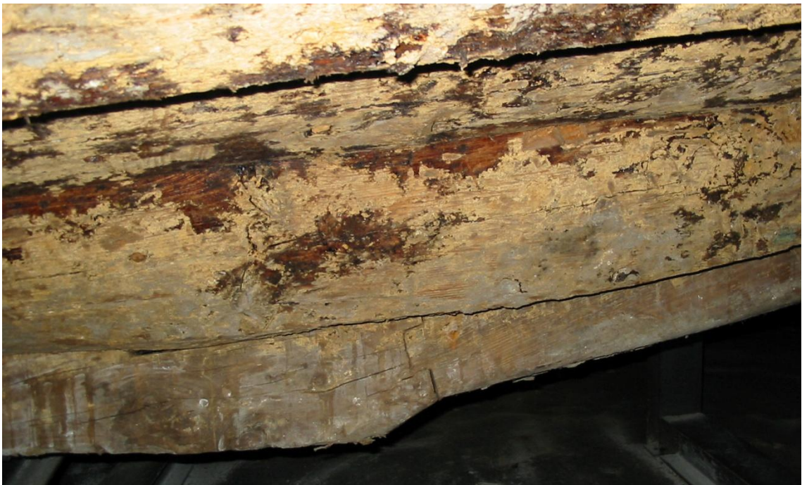
Fig. 356.- Vista lateral del rayo de unión de la quilla con un brión en la roda. (Foto: Autor)
