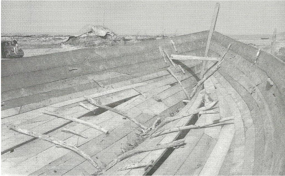
Fig. 36.- Barco a casco primero conocido como Hora de Pakistán (Ibrahim Hyderi) en proceso de construcción. (Greenhill, Morrison 1995: 61)
