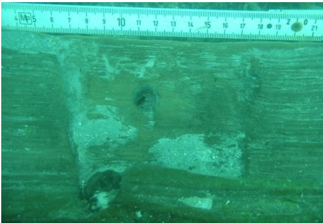
Fig. 472.- Vista superior de la T-6, exfoliada, en la que se aprecia parte de una mortaja y clavija. (Foto: Autor)
