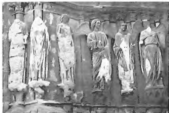
Catedral de Reims — Estatuas que decoran el pórtico norte de la fachada. Antes de la guerra y el 30 de diciembre de 1914, después del incendio causado por los obuses alemanes. Foto del libro Les Allemands destructeurs de cathédrales... Paris 1915
