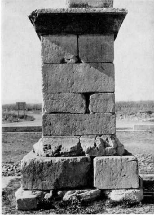
Figura 18.—Pila suroccidental vista desde el SE.
