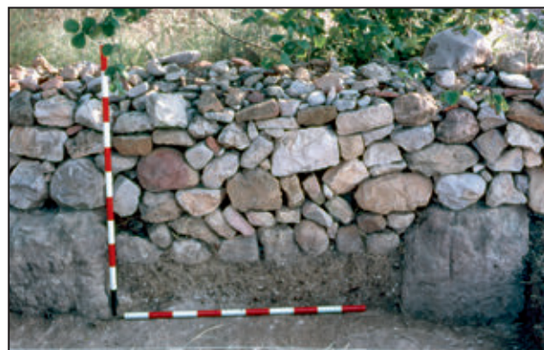
Figura 20. Porta entre el pati B i l'àmbit C, des de l'oest.
