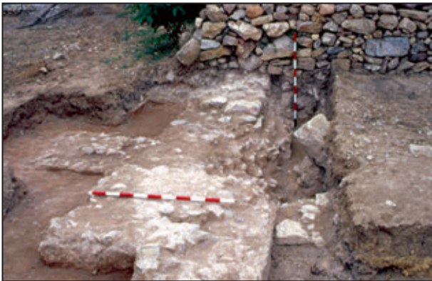
Figura 39. Mur NW de l'edifici A amb un dels contraforts.
