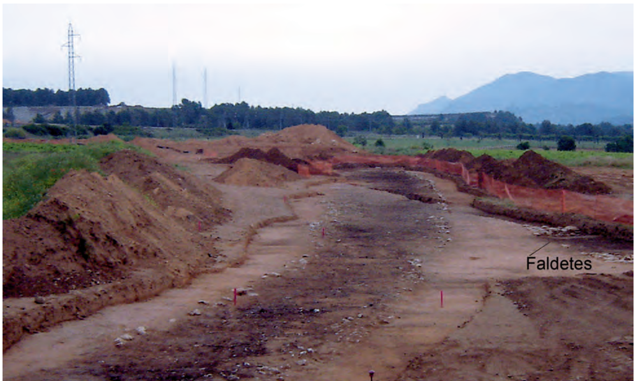
Figura 96. Proceso inicial de excavación del Conjunto 2.
