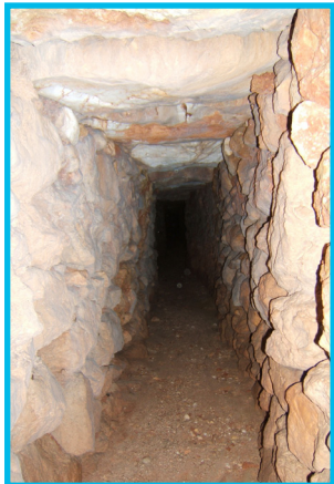
Cubierta adintelada en la galería antigua de la Font del Port (Albaida)
