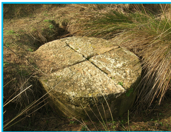
Cubierta de losas labradas de la Mina de Aguas Nuevas (Almansa)
