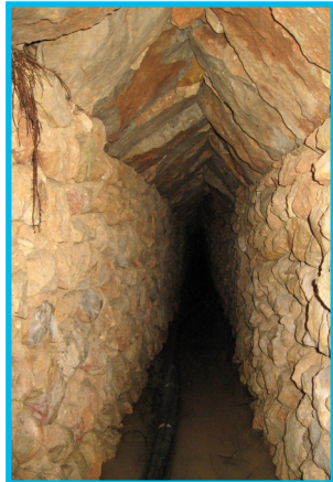
Cubierta con losas dispuestas de forma angular en la Font d'Elca (Salem)
