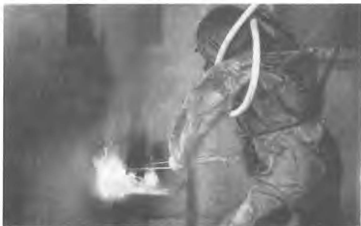
Submarinista cortando bajo el agua corazas de navíos
