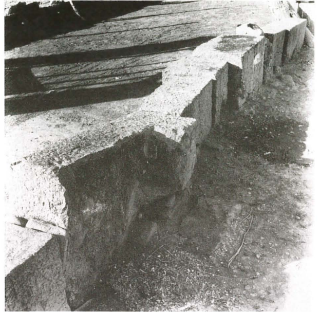
Torre d'Onda. Carreus romans utilitzats per al mur de contenció de La Serratella (E. Safont - 1968).
