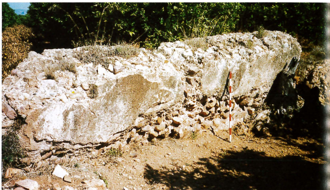
Fig. 38 ▶ Fotografía de un muro de la Bassa Seca (Bextí). Foto F. Arasa.
