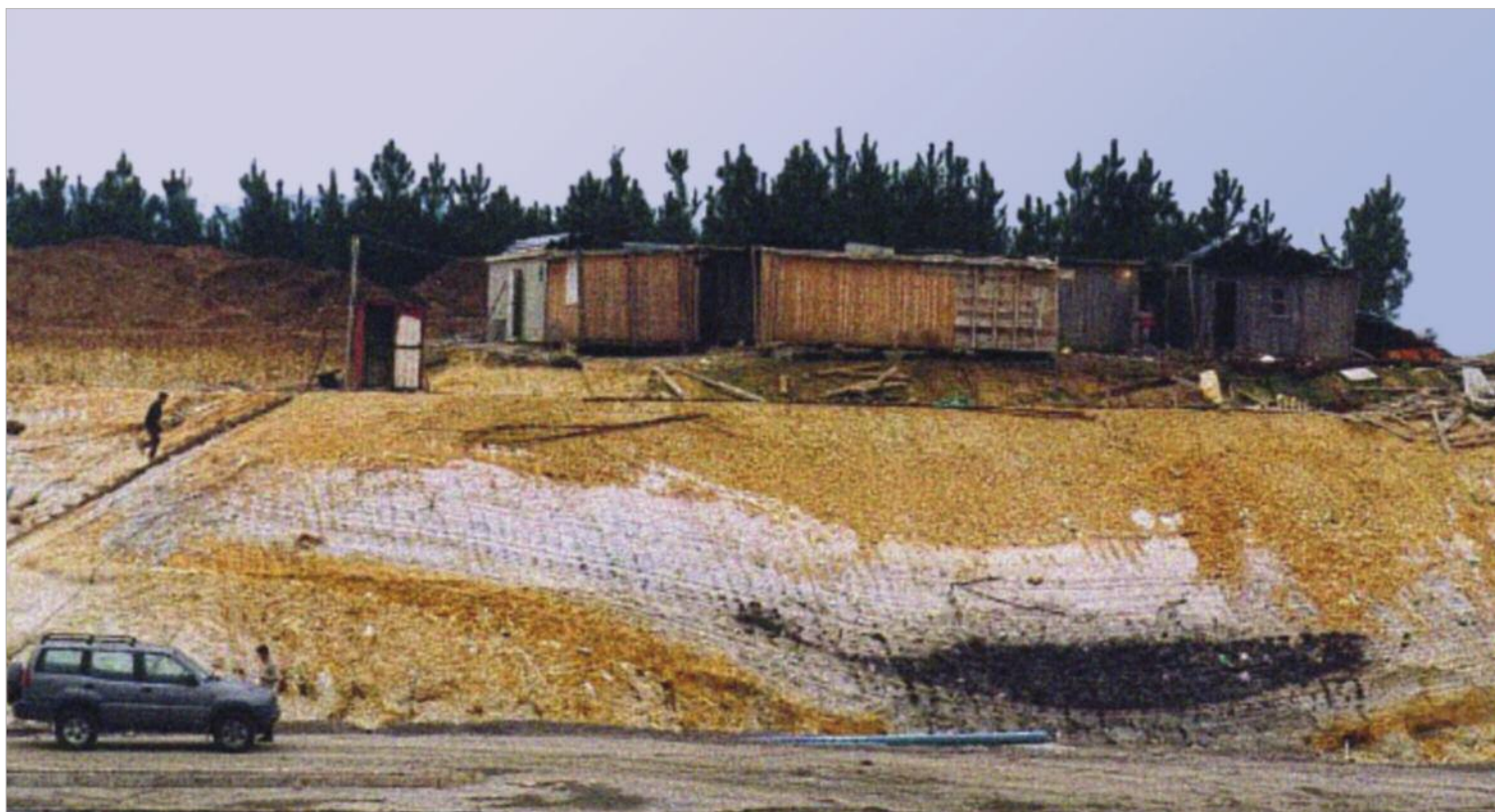
Figura 741. Nivel de arcillas negras pliocenas descubiertas en el talud de la autopista portuguesa A3 a la altura de São Pedro da Torre
