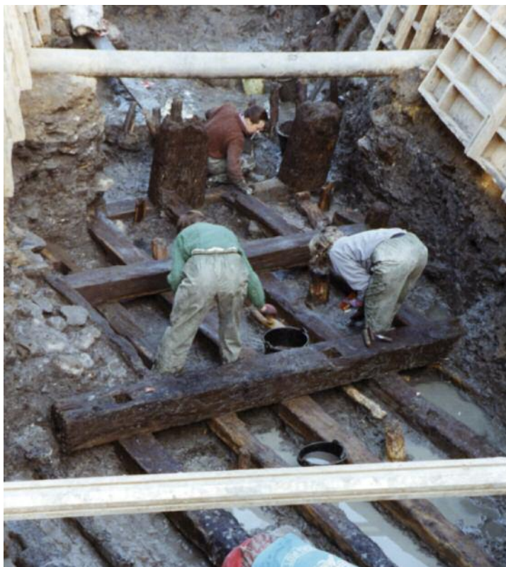
Figura 194. Vista de la excavación de la calle Santiago de Irún
