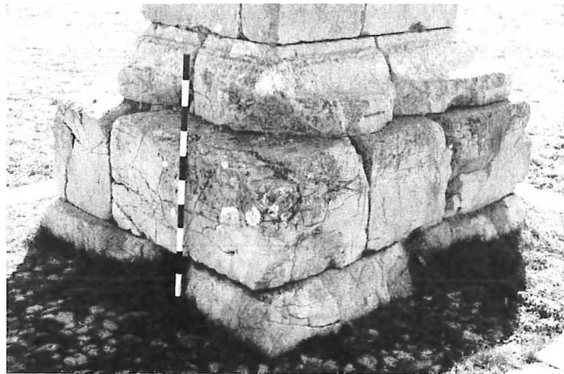
FIGURA 37. Base del pilar SW des del N.
