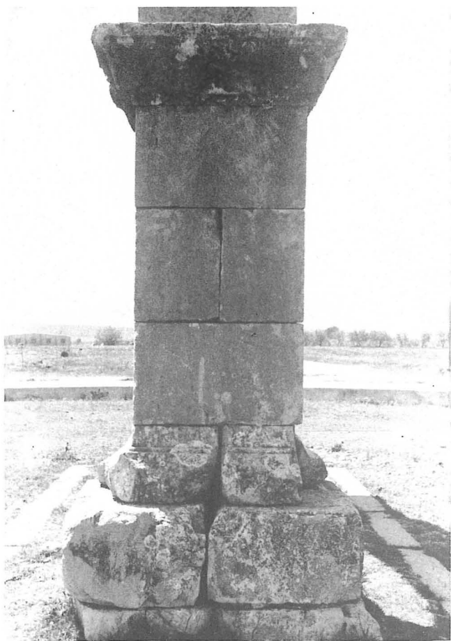
FIGURA 30. Cara SW del pilar SW.
