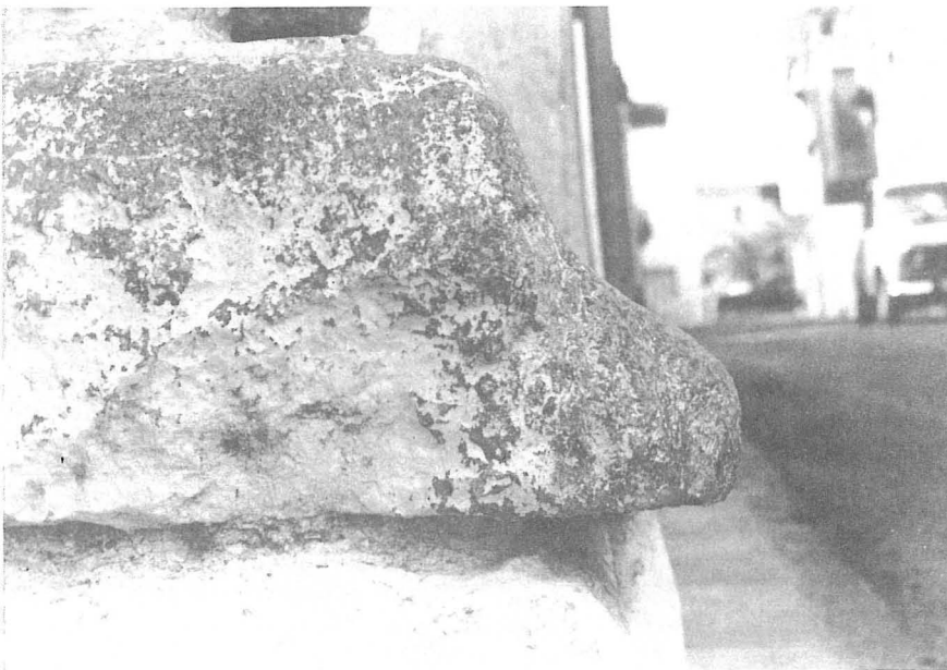
FIGURA 51. Perfil de la motllura de la peça cantonera.
