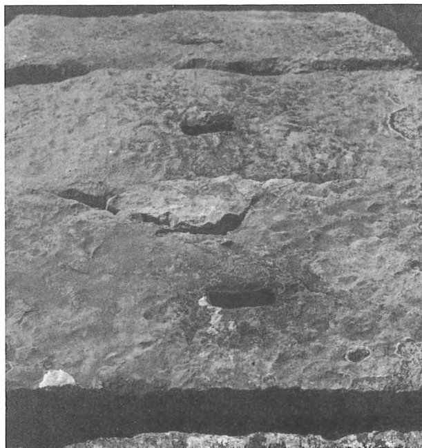
FIGURA 43. Extradós de l'Arc, amb algunes de les mosses existents.
