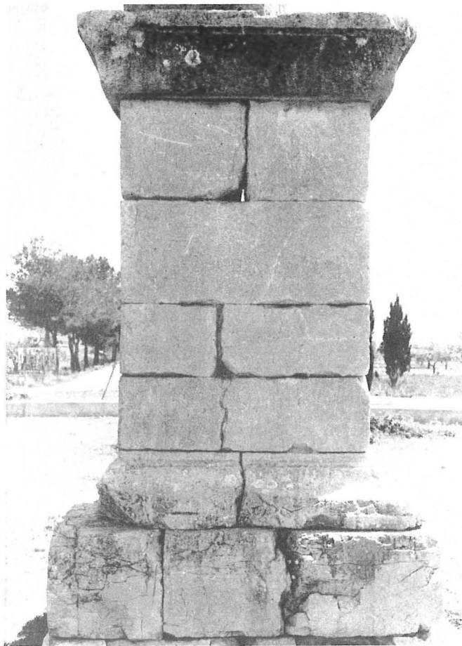
FIGURA 29. Cara NW del pilar NE.
