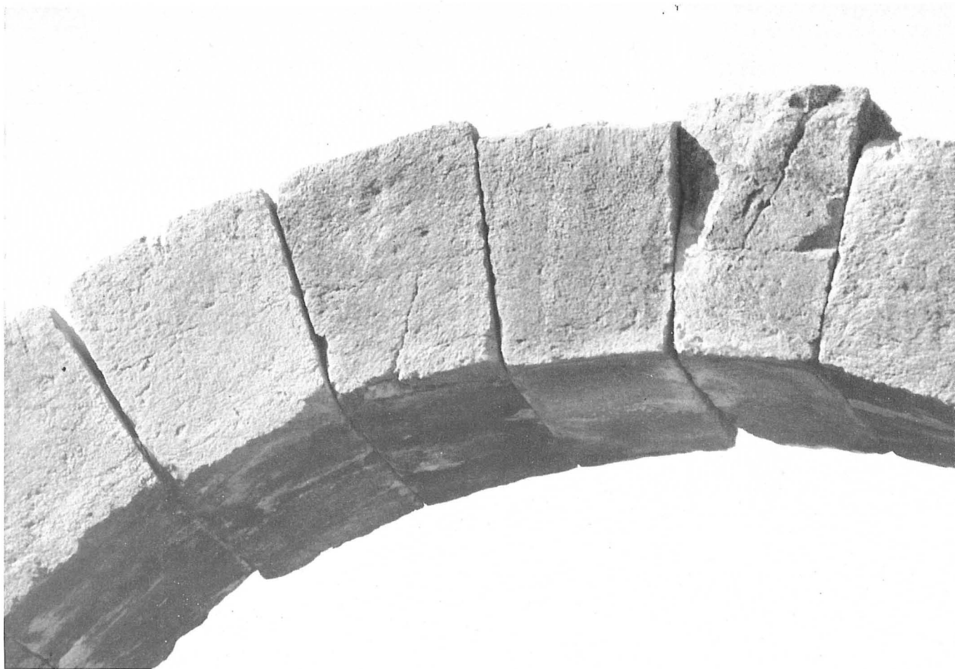
FIGURA 44. Detall de les tres dovelles desencaixades.
