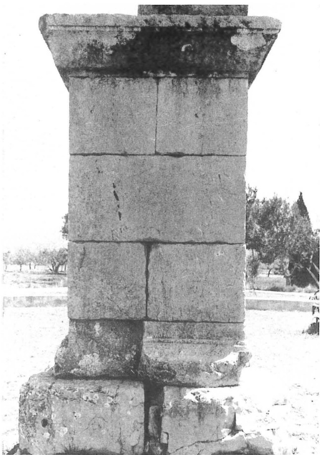
FIGURA 28. Cara NW del pilar SW.
