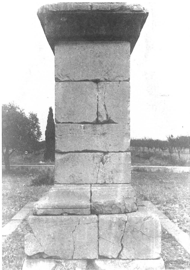
FIGURA 31. Cara NE del pilar NE.
