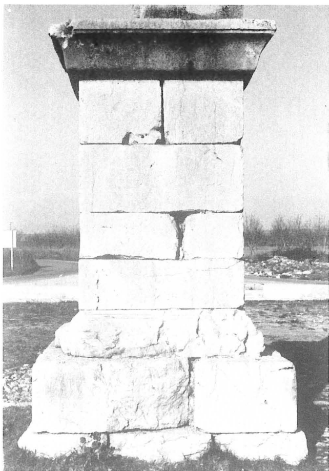
FIGURA 26. Cara SE del pilar SW.
