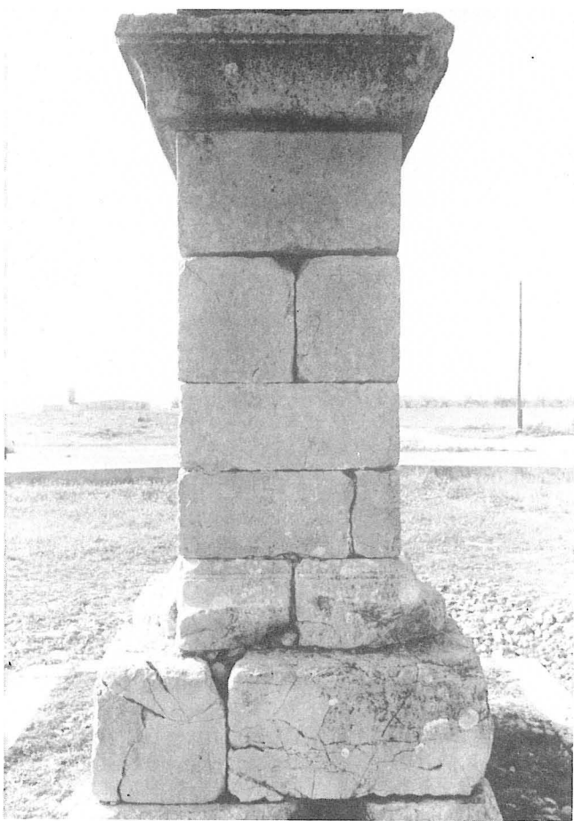
FIGURA 32. Cara NE del pilar SW.
