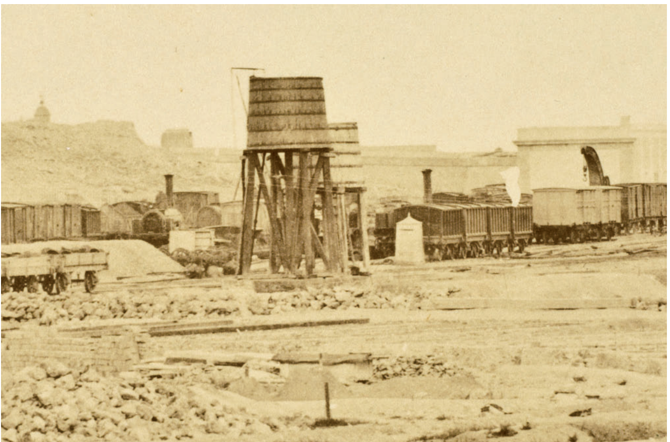
Detalle de la fotografía de la estación de Alicante en 1858, con depósitos de agua y vagones. J. Laurent, Fototeca del IPCE.
