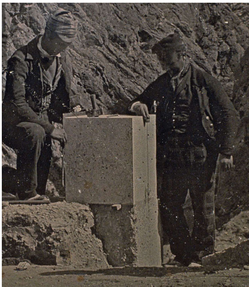
Detalle del daguerrotipo del puente del Cabriel, con dos empleados ajustando un bloque de piedra del pretil. Archivo Lucio del Valle.
