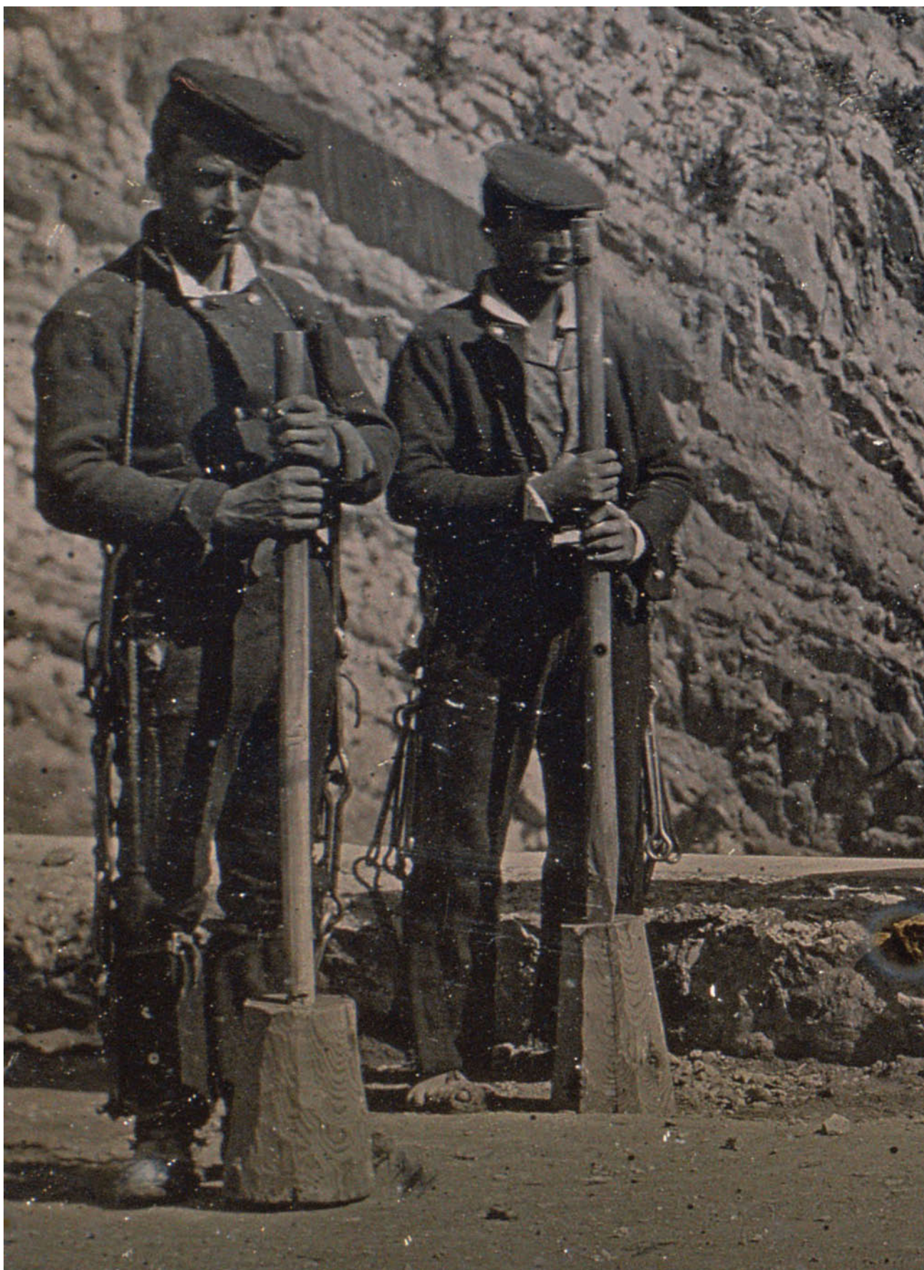
Otro detalle del daguerrotipo del puente del Cabriel, con dos presos trabajando encadenados, apisonando el pavimento. Archivo Lucio del Valle.
