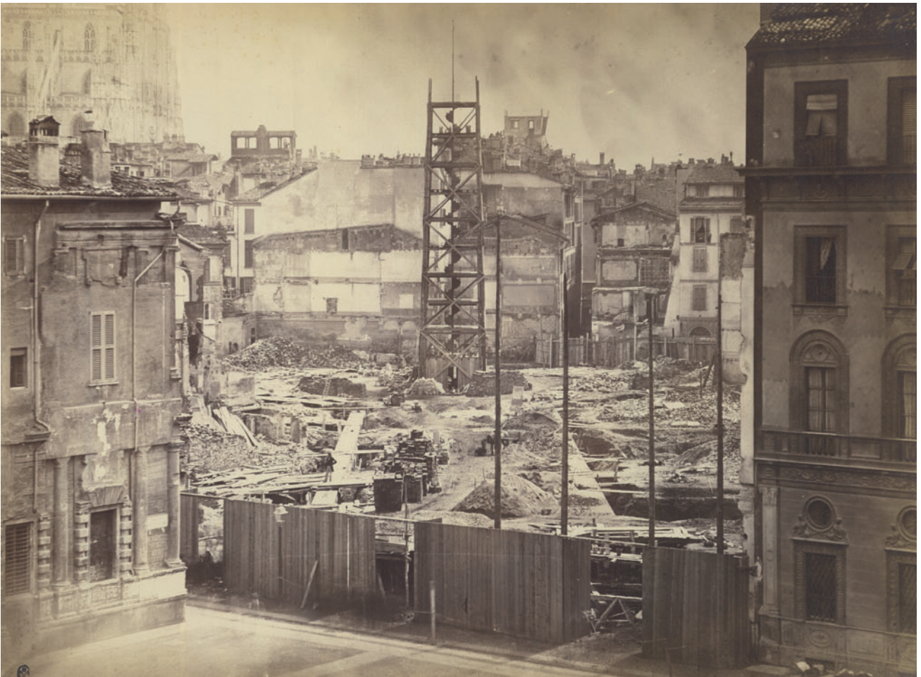
CAFMI, inv. Albo G 107/3 Galleria Vittorio Emanuele II a Milano. Stato dei lavori li 1 Maggio 1865, Milano, 1865. Fotografo non identificato, Civico Archivio Fotografico di Milano. Al centro del cantiere, la grande torre in legname impiegata per la costruzione della cupola della Galleria sventa al di sopra dei tetti degli antichi edifici.
