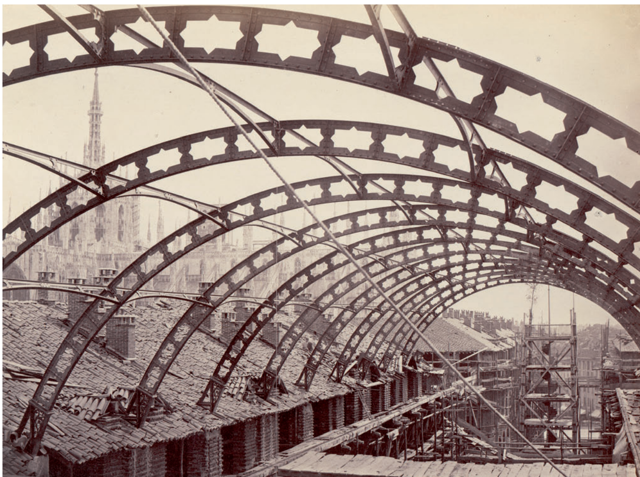
CAFMI, inv. Albo G 107/28 Costruzione della tettoia del braccio settentrionale della Galleria Vittorio Emanuele II, Milano, 1866. Deroche & Heyland, Civico Archivio Fotografico di Milano. La fotografia mostra la copertura della Galleria durante il montaggio della struttura, le cui componenti sono fornite dalla ditta francese H. Joret. Sullo sfondo si riconosce il profilo del Duomo, con il tiburio e la guglia maggiore.
