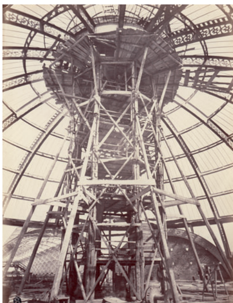
CAFMI, inv. Albo G 107/31 Cantiere della Galleria Vittorio Emanuele II. Particolare dell'impalcatura per la cupola, Milano, 1866. Deroche & Heyland, Civico Archivio Fotografico di Milano. La grande cupola in ferro sovrasta lo spazio centrale della Galleria, chiamato "Ottagono". La fotografia è ripresa dal piano del tavolato eretto per agevolare le operazioni di costruzione.
