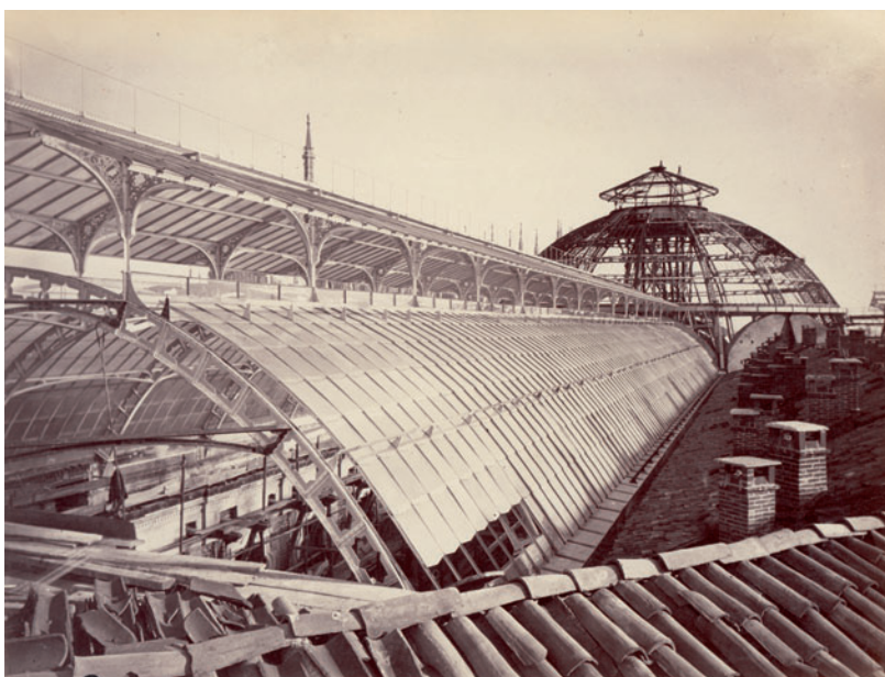
CAFMI, inv. Albo G 107/35 Tettoia della Galleria Vittorio Emanuele II e cupola in costruzione, Milano, 1867. Deroche & Heyland, Civico Archivio Fotografico di Milano. La posa delle lastre di vetro rigato sulla tettoia della strada coperta e, in secondo piano, lo scheletro della cupola in costruzione.
