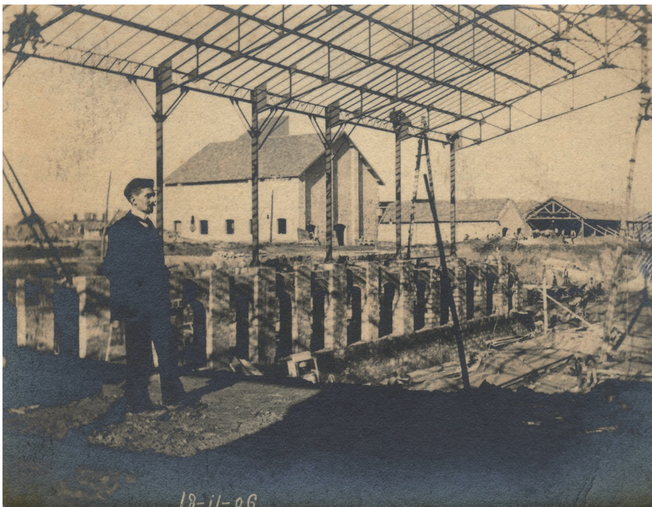
Nave de Gasógenos en construcción, 1906, Archivo Arija.
