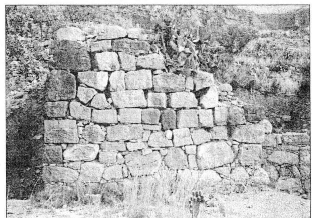
Lámina II: Aspecto de la muralla ibérica de Arse-Saguntum (siglo IV a.C.).
