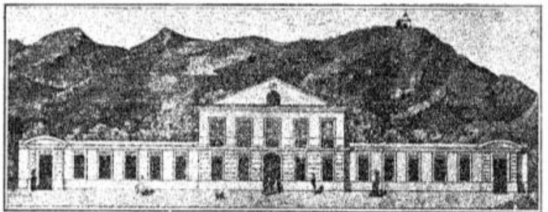
Fig. 5-4 Vista general del balneario de Carratraca 713 .
