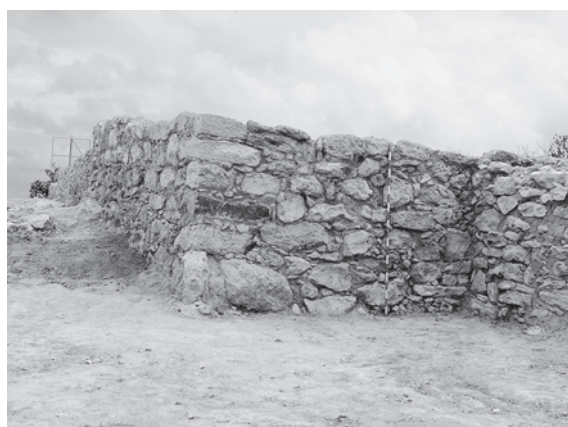
Torre 1, costat sud-oest després de la consolidació de 2007.
