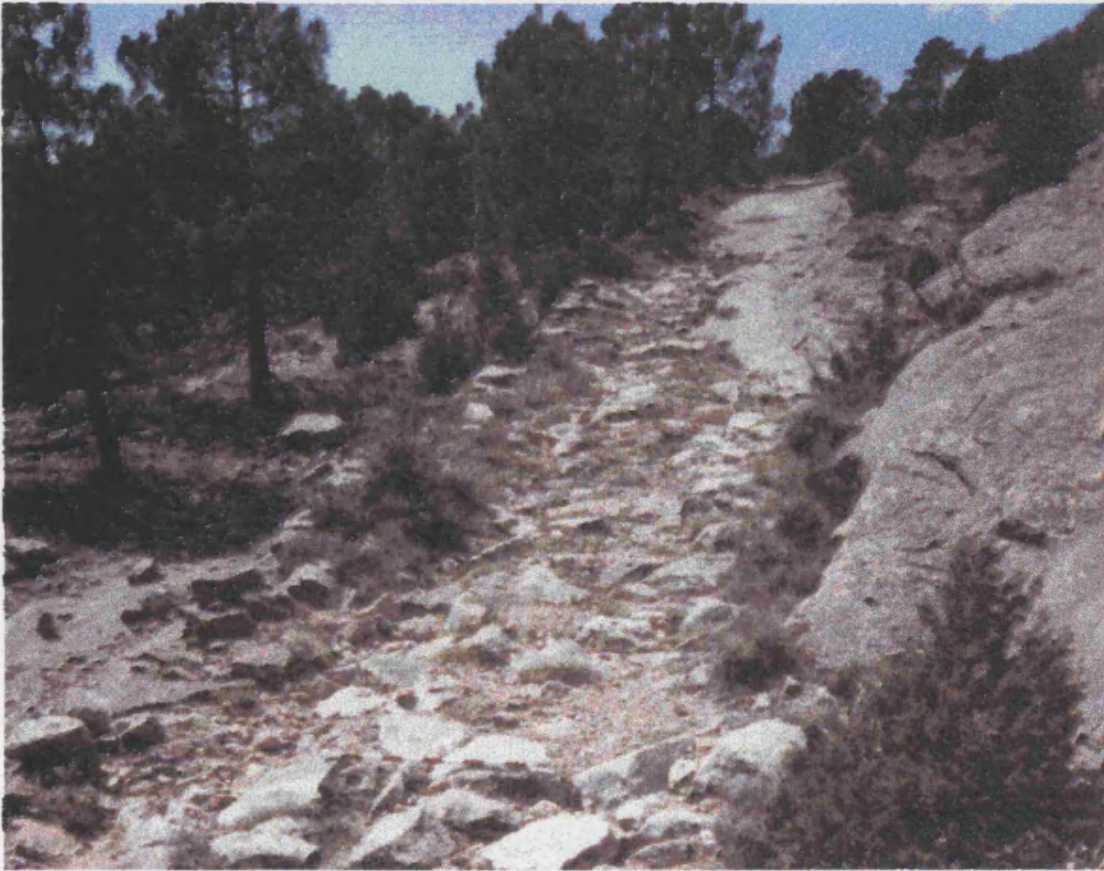
Figuras 28 y 29. Muro de contención y empedrado en el Camino de Gea de Albarracín a Albarracín.
