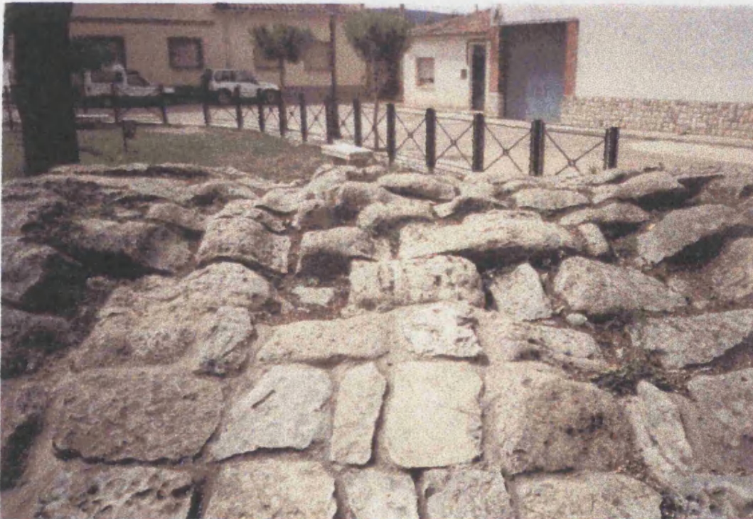
Figuras 16 y 17. General y detalle del puente de Calamocha.
