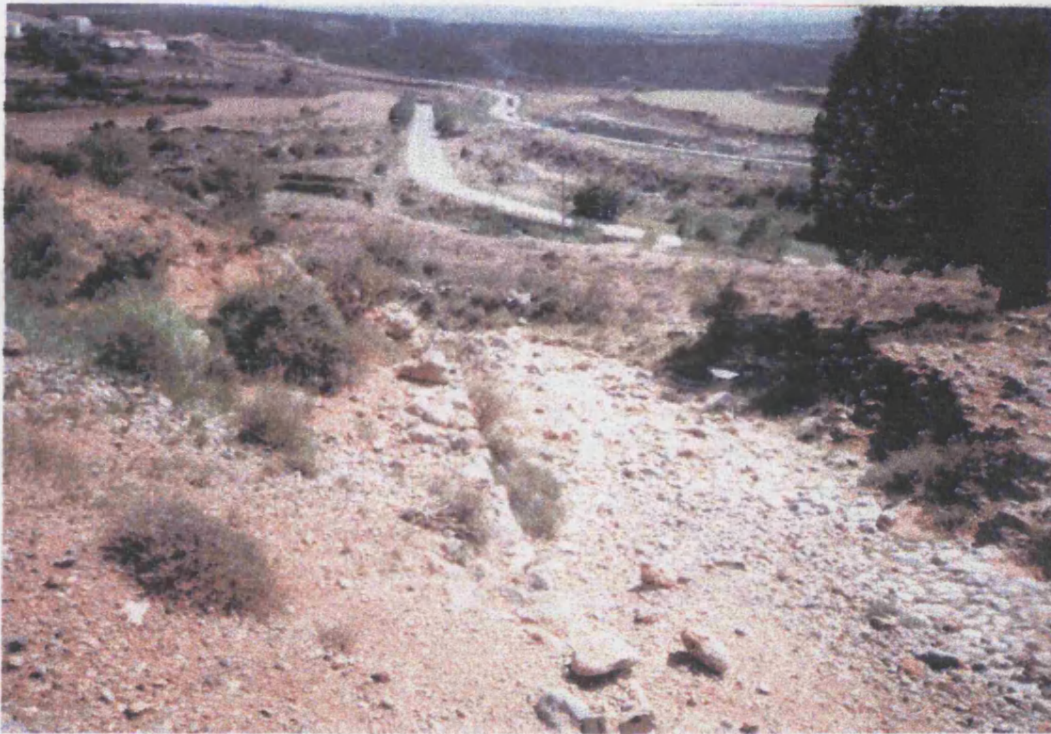
Figura 7. El antiguo camino de Teruel junto a la Puebla de Valverde. Al fondo, la antigua y la actual carretera.
