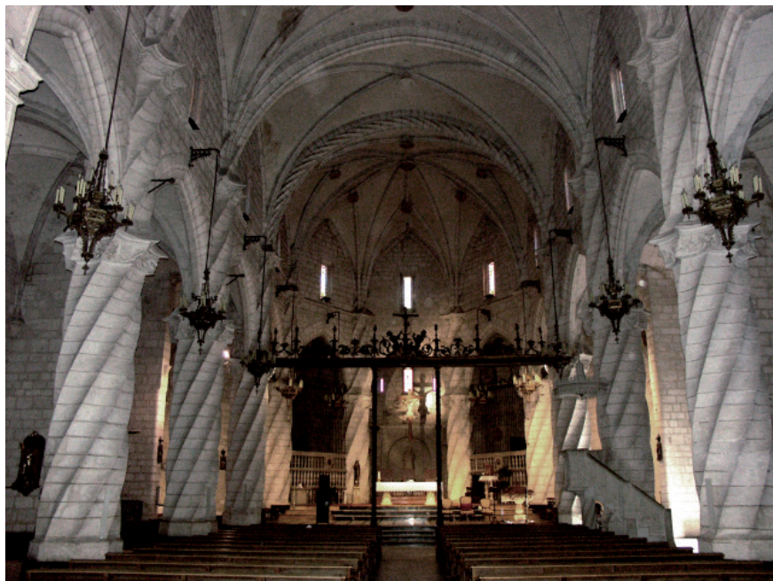
Interior de la iglesia de Santiago de Villena.
